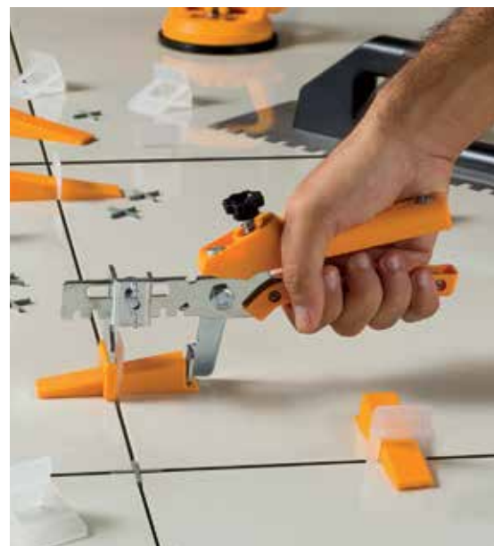
Sistema de Nivelamento
