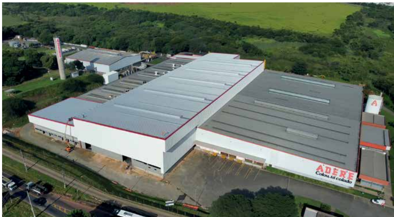
O parque fabril da ADERE passa a ter 30 mil m 2 construídos e inclui uma nova área para o laboratório próprio, ainda mais robusto e tecnológico.
