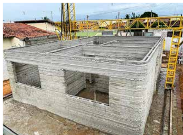
Casa construída com tecnologia de impressão 3D
