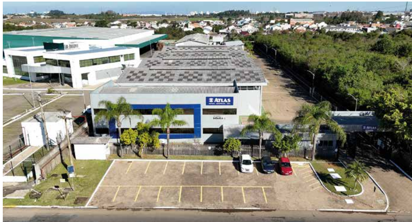
Fábrica onde são produzidas as Fitas Adesivas, em Canoas, RS
