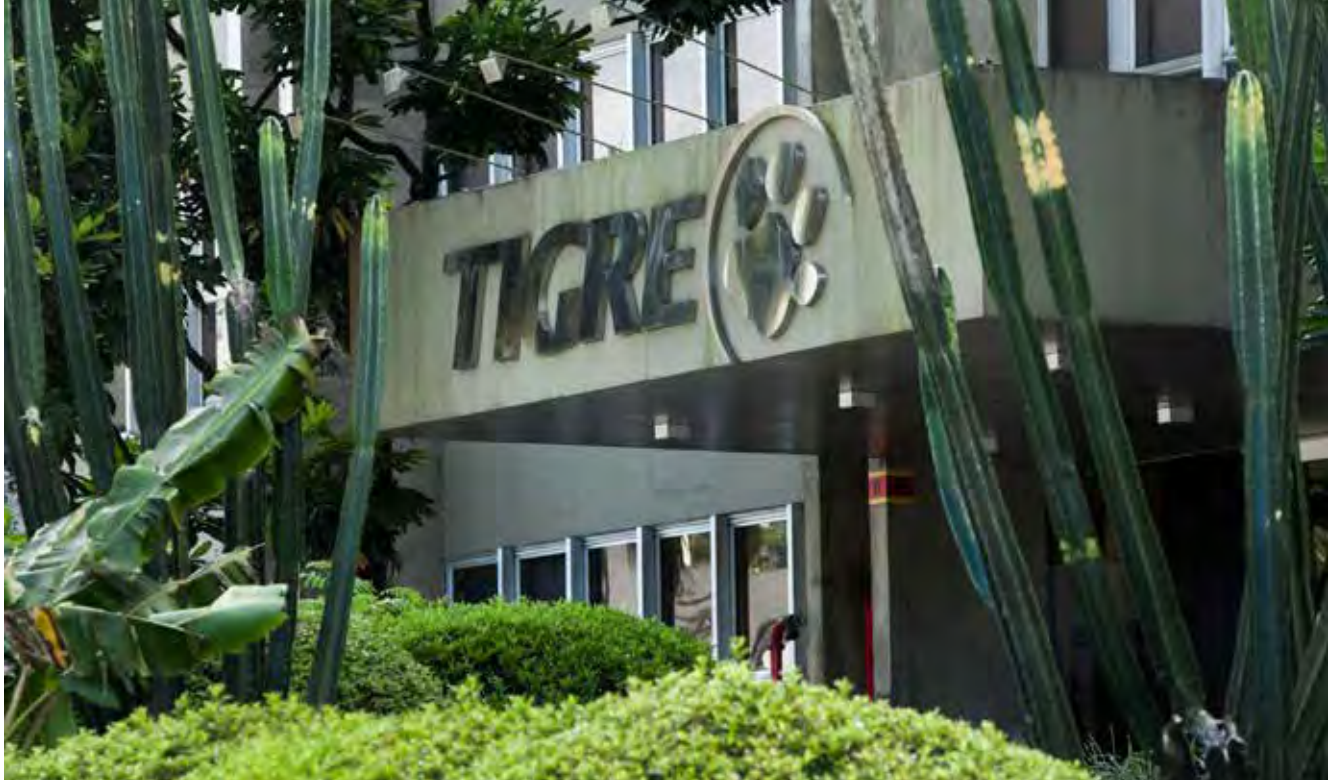
Fachada da fábrica da Tigre em Joinville, SC
